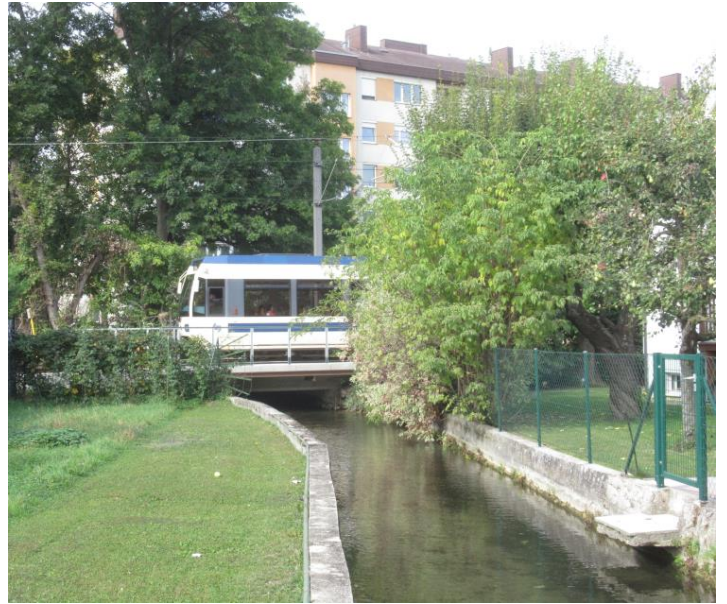
Eine Garnitur der Badner Bahn kreuzt den Mühlbach vor der Gefällestufe, Standort nicht zugänglich. Quelle: K. Berger
