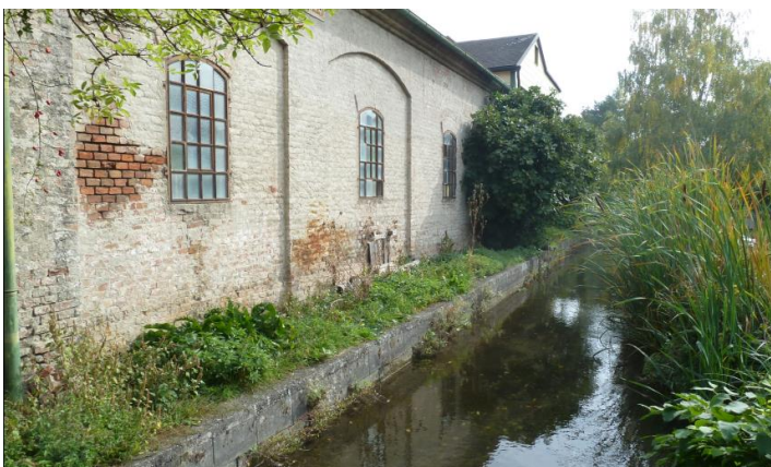
Ehemaliger Gebäudeteil der Wüste-Fabrik, nicht zugänglich
