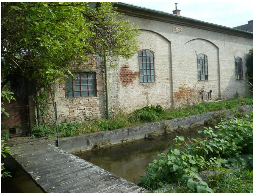
Ehemaliger Gebäudeteil der Wüste-Fabrik, Wüstegasse 62, nicht zugänglich
