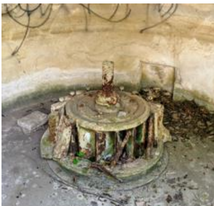
Francis-Turbine im Badener Mühlbach, Rollettgasse 4
