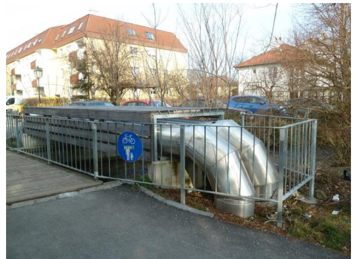
Mühlbach bei der Querung der Schwartzstraße
