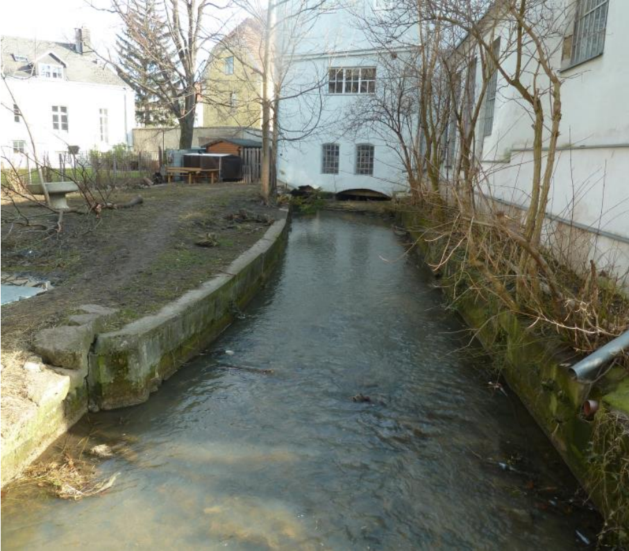
Mühlbach und ehemaliges Mühlengebäude vor der Gefällestufe
