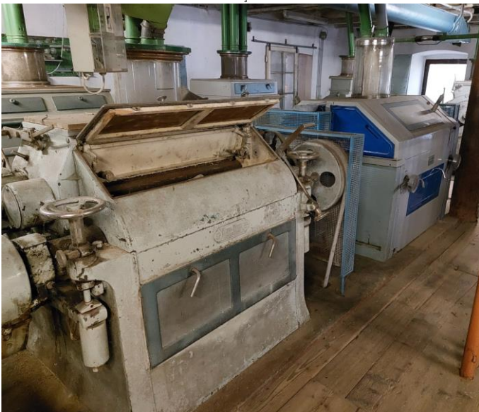
Walzenstühle erledigen den eigentlichen Mahlvorgang. Sie lösen die Mühlesteine ab.
