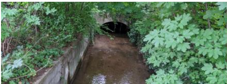
Mühlbach nach der Trottmann-Mühle bei der Hildegardgasse 3
